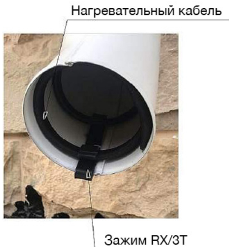
Рис. 4 (Крепление нагревательного кабеля с использованием зажима RX/3T, сливное колено)
